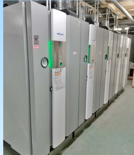
ボイラー更新による熱効率アップ(2020年12月)
