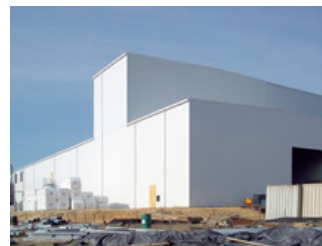
建設中のペプチド工場
